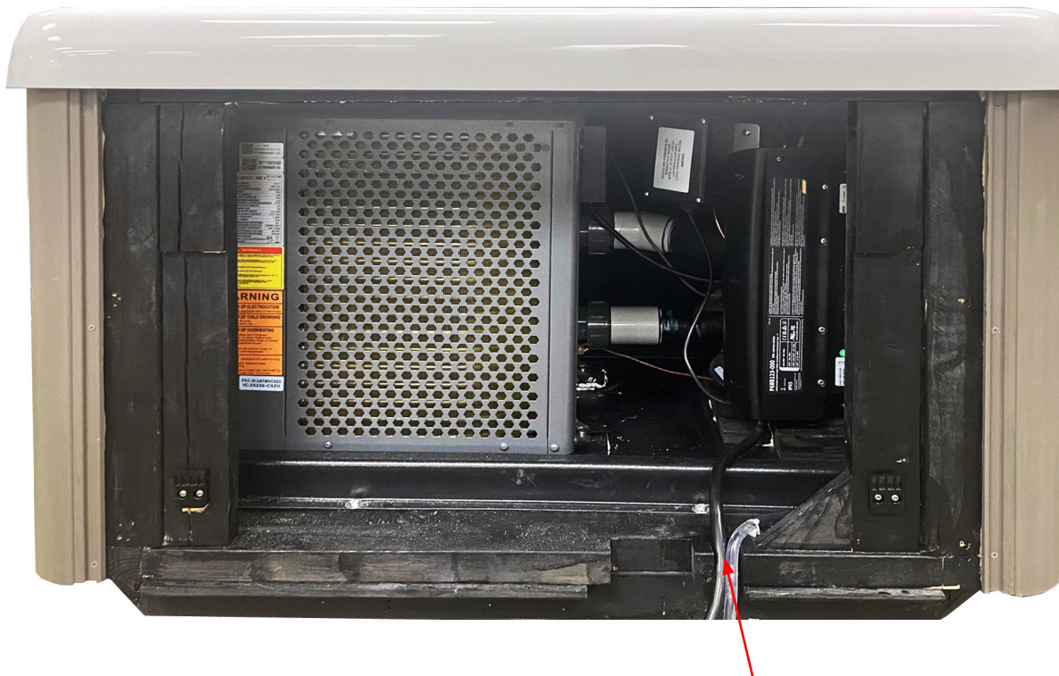
voedingskabel & afvoerbuys in uitsnijding
