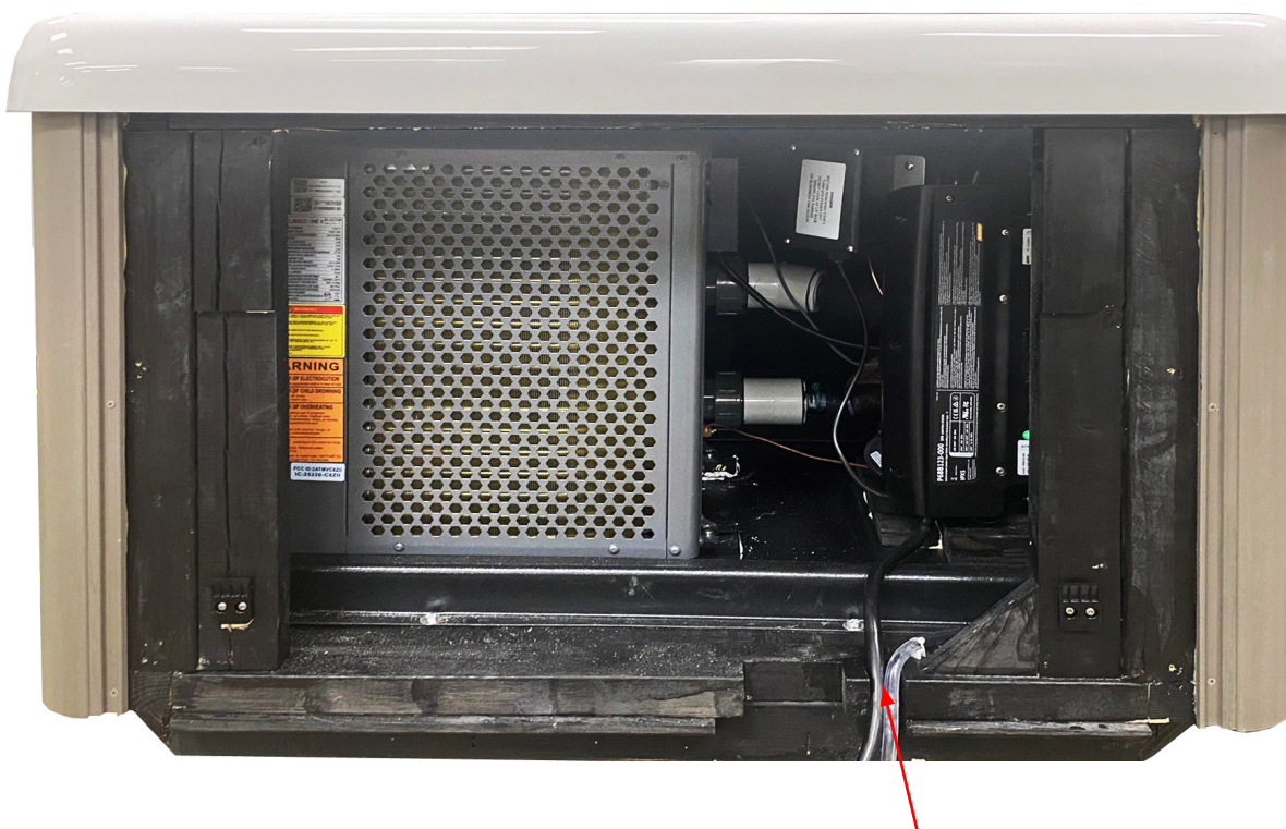
Netzkabel und Abflussrohr im ausgeschnittenen Bereich
